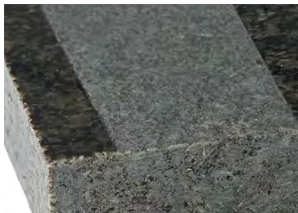
Oberfläche poliert und mit Rutschstreifen
